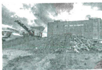
Economie circulaire sur les chantiers de déconstruction
