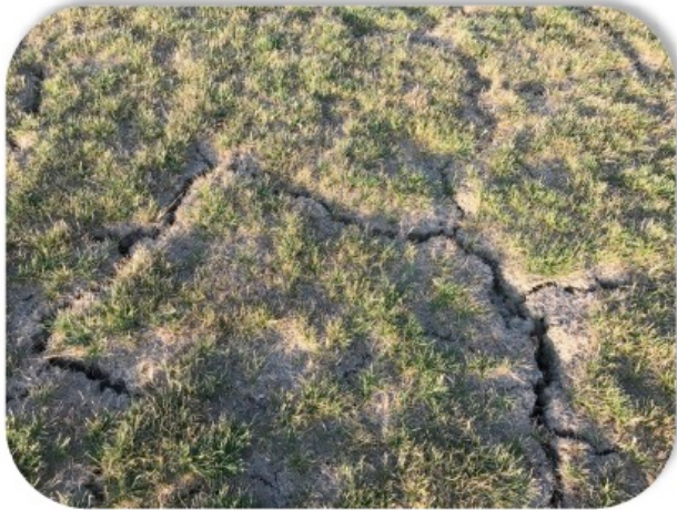
Exemple de retrait des argiles en période de sécheresse
