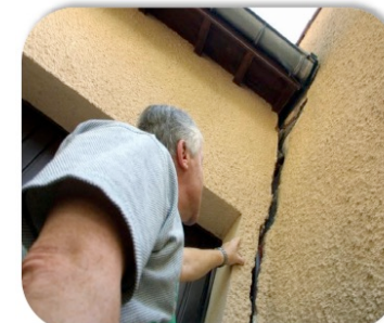
Exemple de dégâts causés par le retrait gonflement des argiles sur l'habitat
