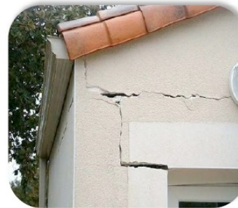
Exemple de dégâts causés par le retrait gonflement des argiles sur l'habitat
