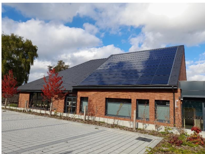
Figure 20 : Panneaux photovoltaïques à Burbure
