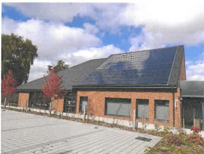
Figure 20 : Panneaux photovoltaïques à Burbure
